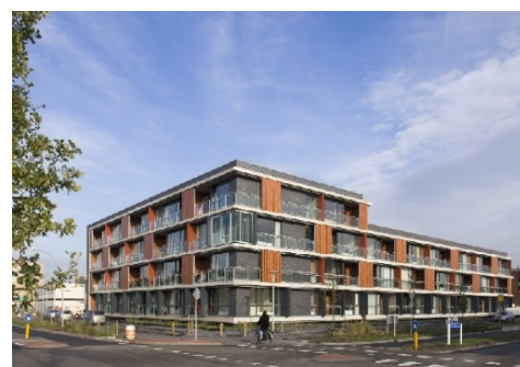
'Ensemble' Apartments Belvédèrelaan 383-463.
